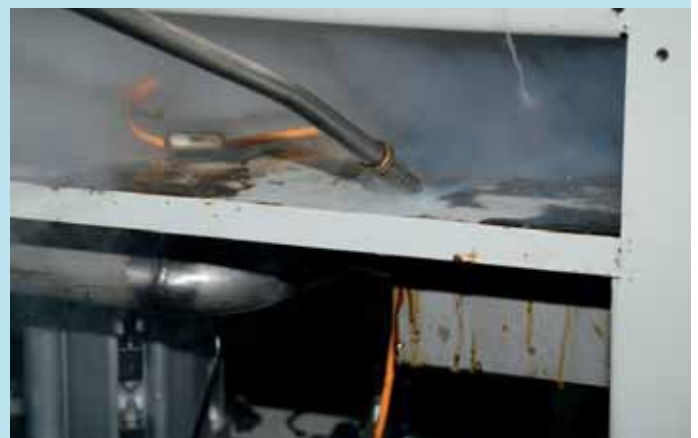
Dampf wird typischerweise zur Reinigung von öligen und fettigen Verschmutzungen eingesetzt.
